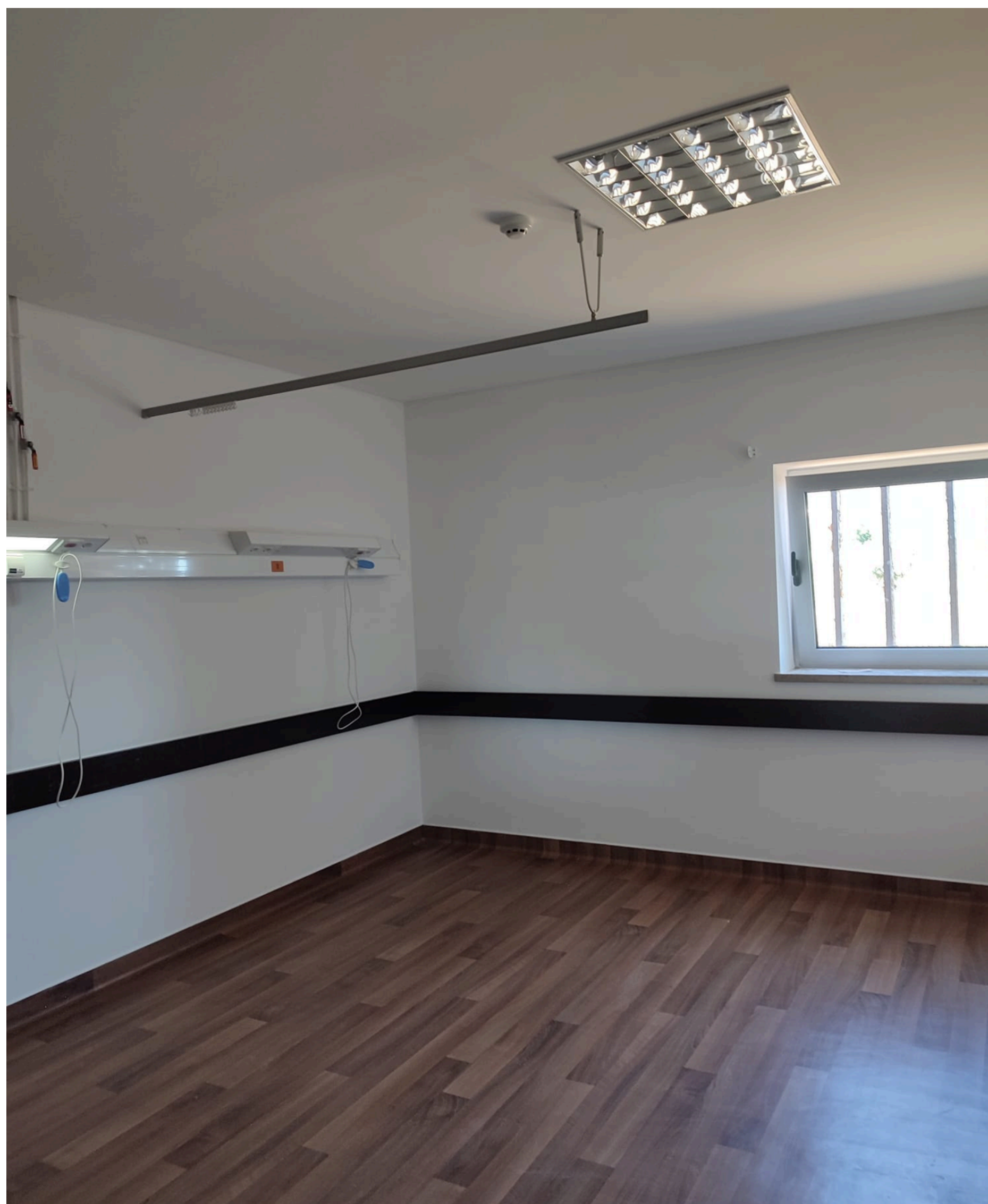
Pormenor de uma das salas já intervencionadas
